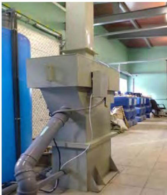
Пример практической реализации разработанных технологий и технических решений. Участок переработки кислотно-щелочных, хром- и цианосодержащих сточных вод: общий вид и электрофлотатор (разработчик Кисиленко П. Н.).
