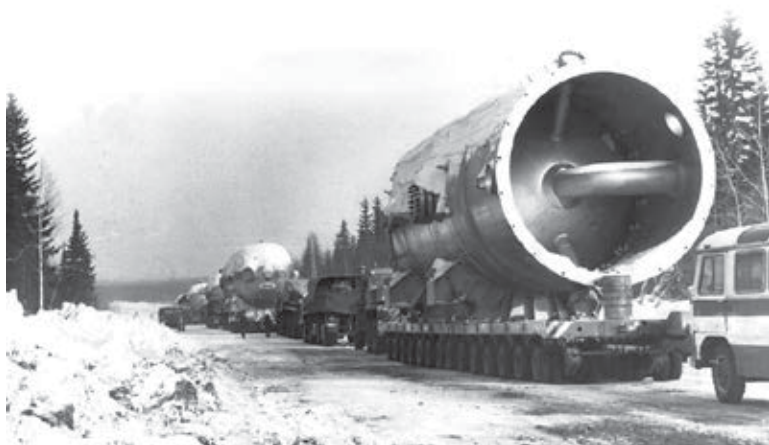
Доставка оборудования в Губаху
